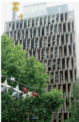
メルボルン市庁舎省エネビル：屋上に風力換気の黄色い塔が見える。コンピュータ操作の木製ルーバーで北からの強い日射を遮断している。
