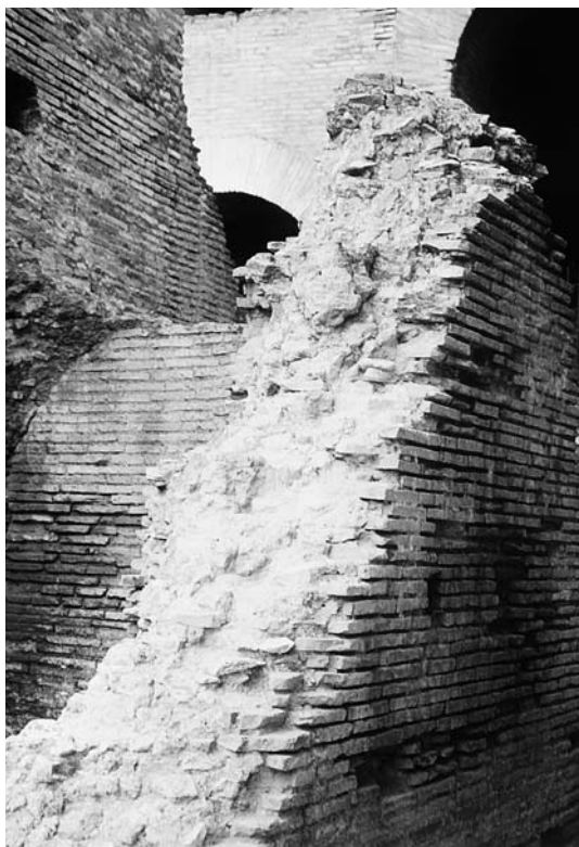
二千年近く前に作られたコロッセウムのコンクリート断面
